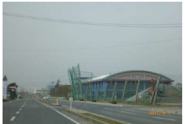
学校のフェンスが倒れている
