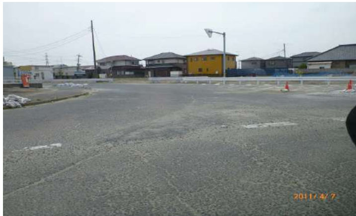
液状化で道路がガタガタになっています。
